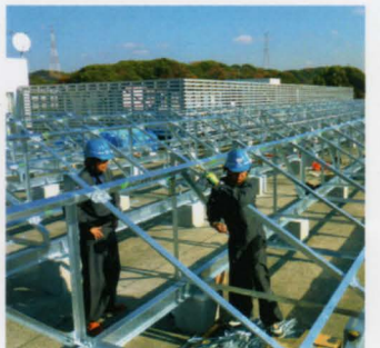
集熱器の型枠設置工事
