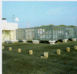
集熱器の基礎工事
