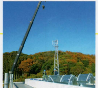
集熱器の取付工事
